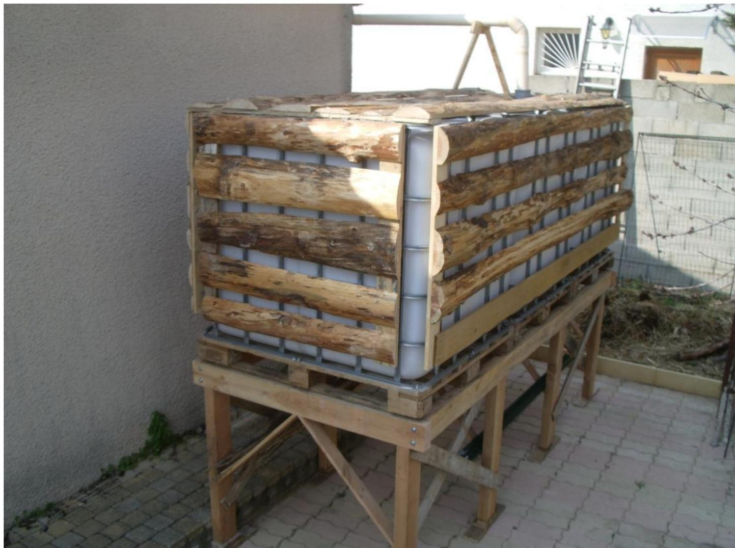
Nous allons voir la construction d'un système de récupération d'eau de pluie alimenté par 118 m<sup>2</sup> de toit. Pour les amateurs de chiffres, la toiture est en pente de 24° (ou 45%), ce qui représente une surface de 108 m<sup>2</sup> en projection horizontale.
